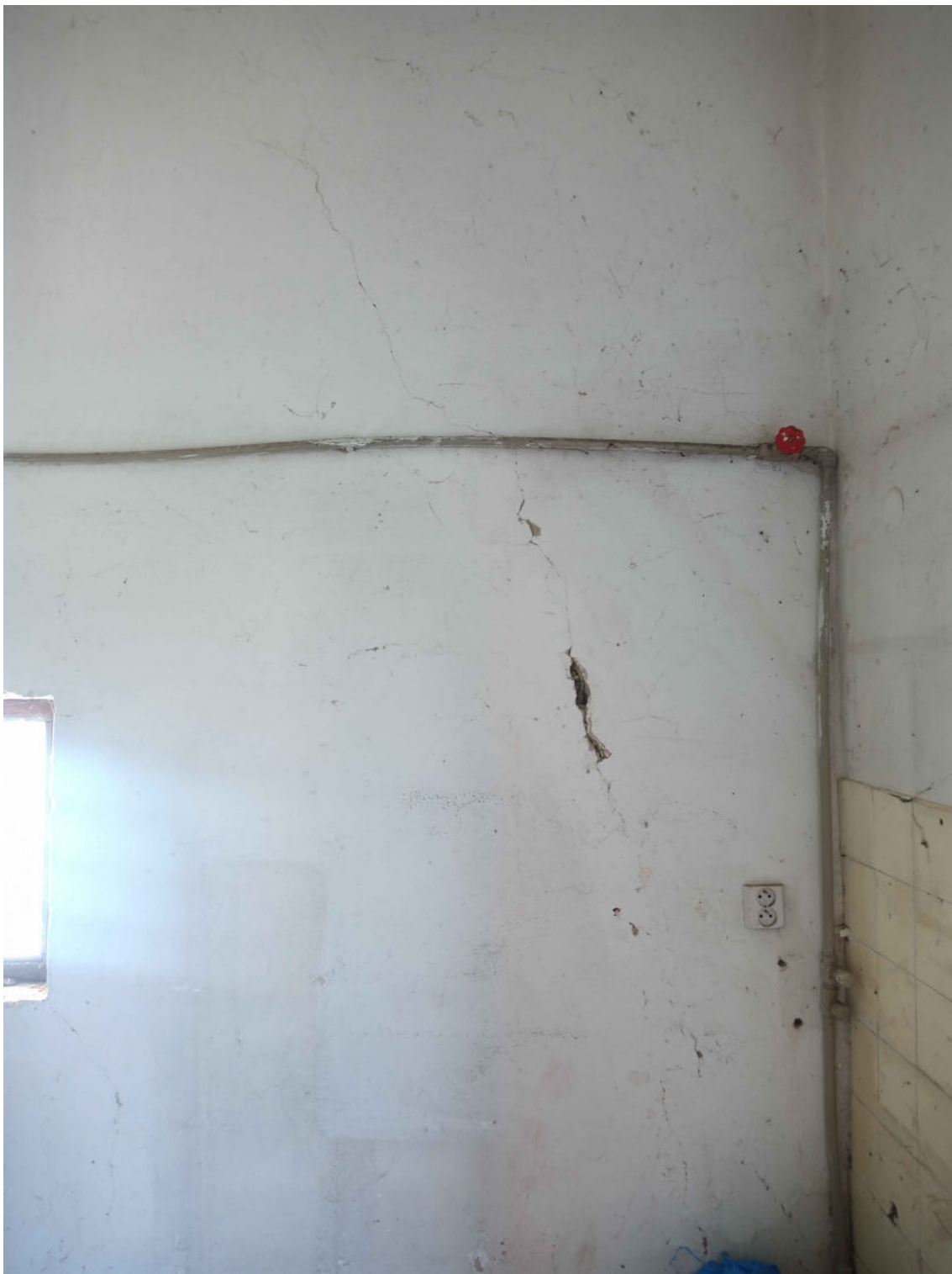
Obr. 18 - Trhlina kopírující šikmý trám hrázdného zdiva
