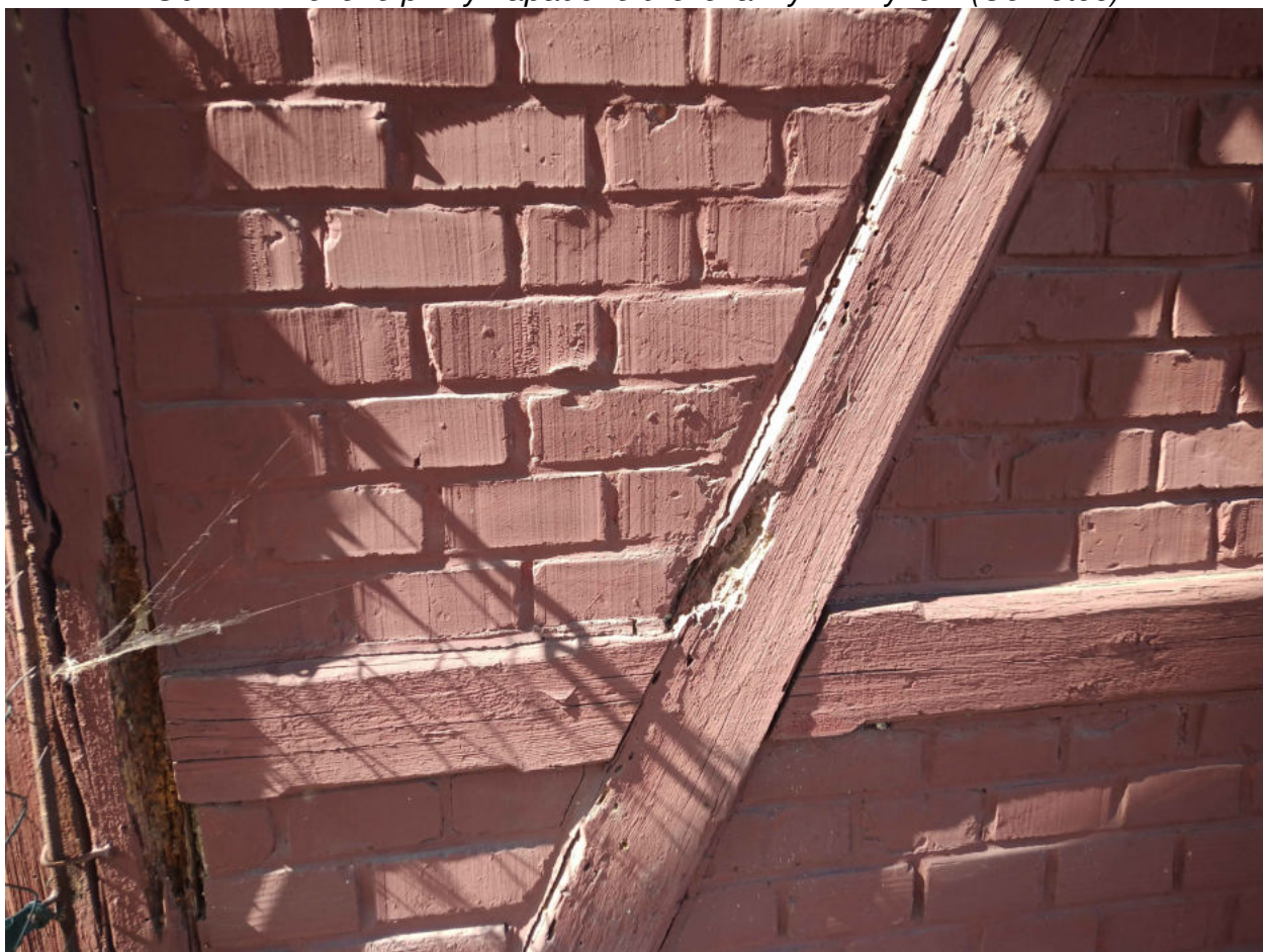
Obr. 8 - Dřevěné prvky napadené dřevokazným hmyzem (Tesařík)
