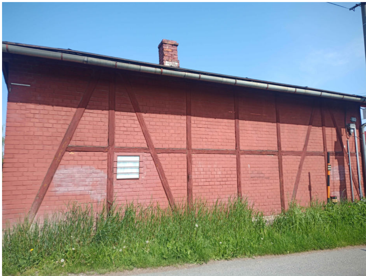
Obr. 2 - Hrázdná část zdiva
