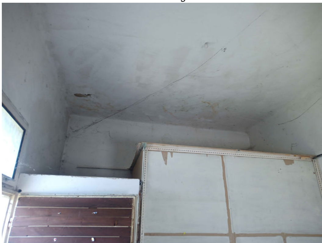
Obr. 17 - Zatékání ve vnitřní části
