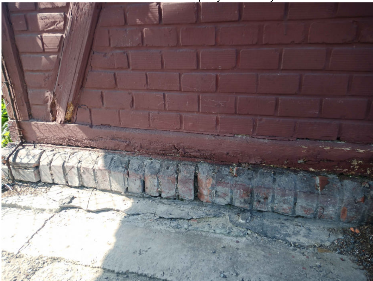
Obr. 6 - Vlhké a degradované dřevěné prvky nad základy
