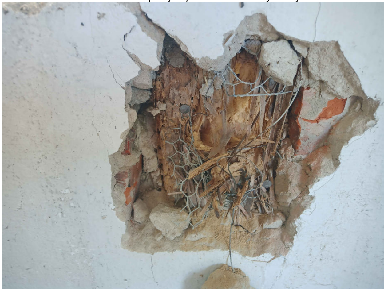
Obr. 11 - Napadení dřevokazným hmyzem také uvnitř zdiva
