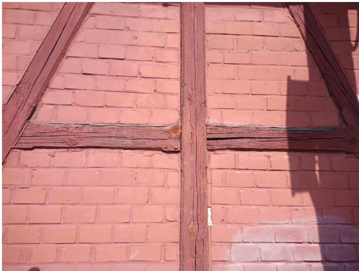
Obr. 4 - Výrazně popraskané a seschlé dřevěné prvky
