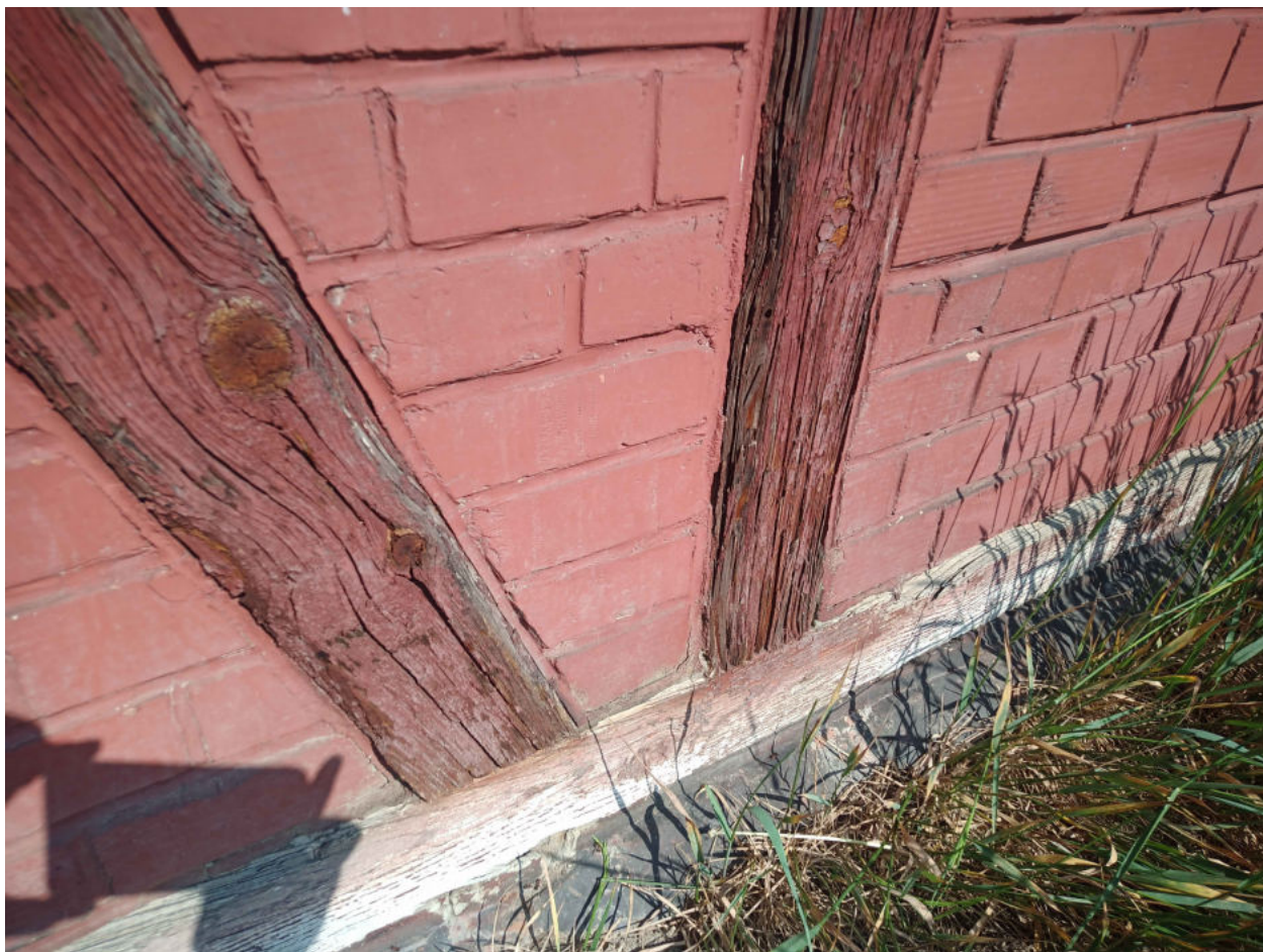
Obr. 5 - Vlhké dřevěné prvky nad základy
