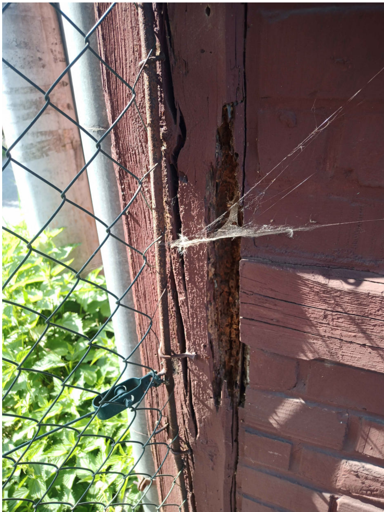
Obr. 9 - Dřevěné prvky napadené dřevokazným hmyzem
