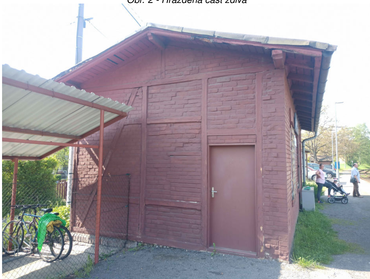
Obr. 3 - Hrázdná část zdiva
