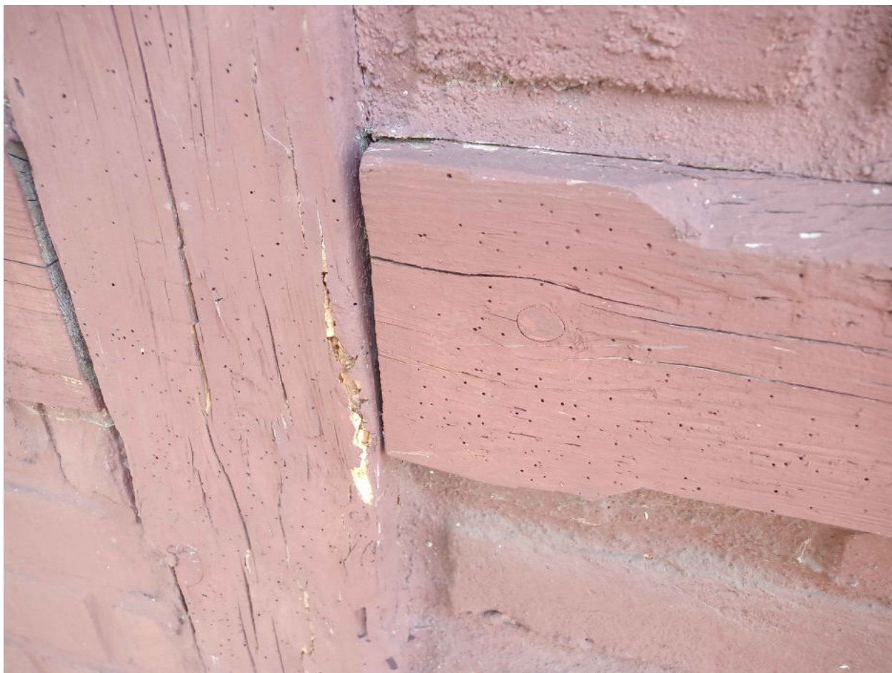
Obr. 7 - Dřevěné prvky napadené dřevokazným hmyzem (Červotoč)
