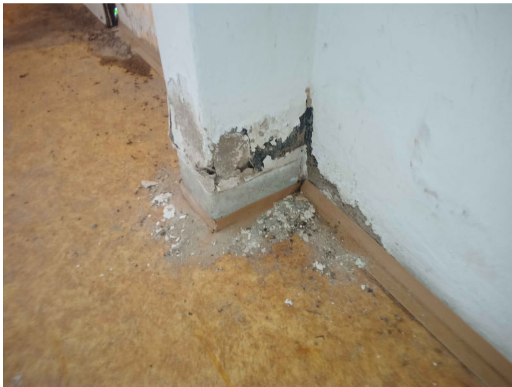
Obr. 16 - Vlhkostní degradace zdiva
